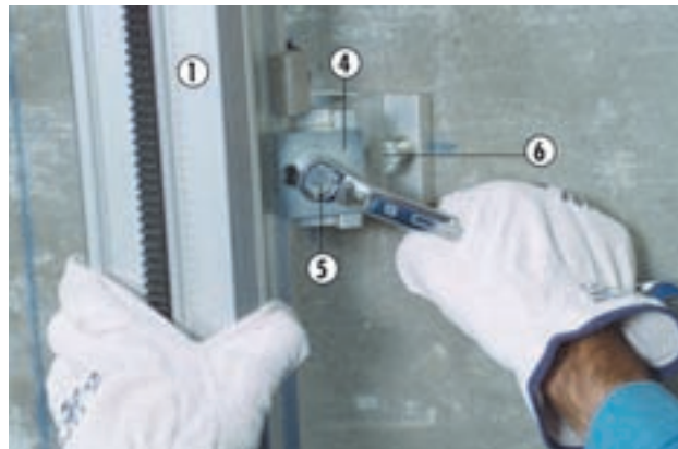
Montage du pied de rail avec pied de rail standard
