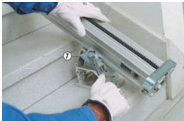
Montage du pied de rail pour coupes en biais et inclinées
